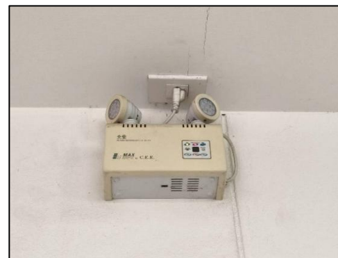
รูปที่ 29 ติดตั้ง Emergency Light
