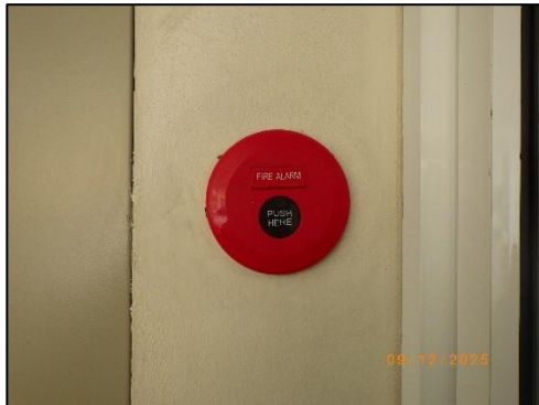
รูปที่ 32 กริ่งสัญญาณเตือนอัคคีภัย
