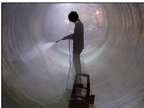
รูปที่ 61 ทำความสะอาดถังเก็บน้ำ
