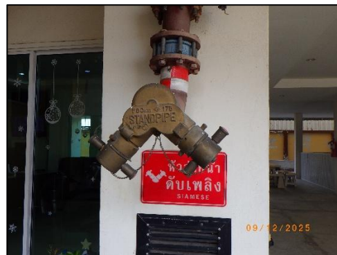
รูปที่ 27 หัวรับน้ำดับเพลิงภายนอกอาคาร
