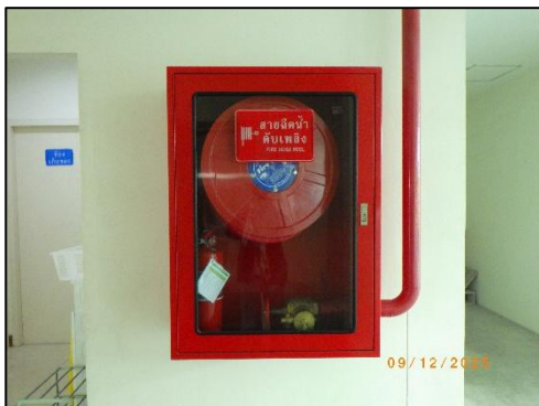
รูปที่ 26 ตู้เก็บสายฉีดน้ำดับเพลิงพร้อมอุปกรณ์
