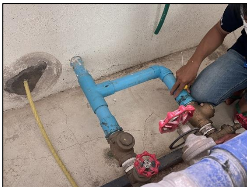
รูปที่ 60 ช่างซ่อมบำรุงตรวจสอบรอยรั่วของเส้นท่อประปาหรือปั้มน้ำ
