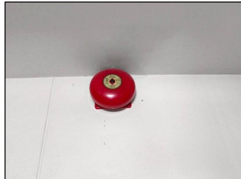
รูปที่ 32 กริ่งสัญญาณเตือนอัคคีภัย
