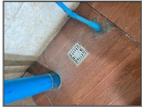
รูปที่ 23 ท่อรวบรวมน้ำจากการล้างห้องพักมูลฝอยรวม
